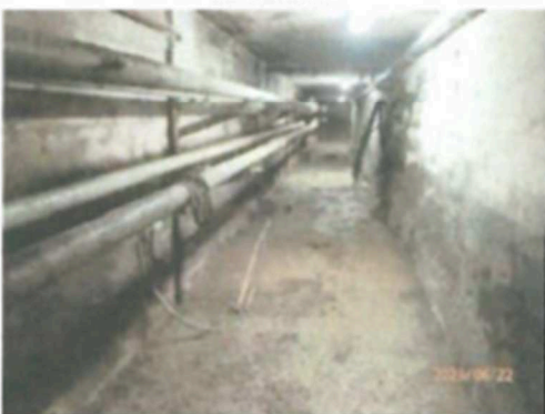
podchod pod silnicí
