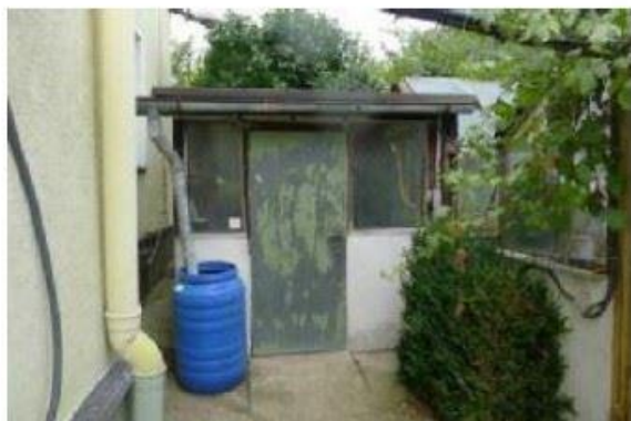
Vstupní část skleníku na stp.č. 605/2
